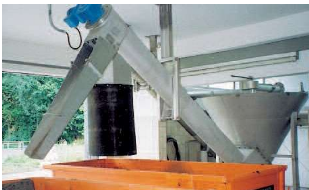
Класифициращ шнек транспортира отделения пясъчен материал от сепариращата камера в контейнер.
