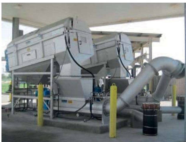
Промиване и отделяне на всички груби частици > 10 мм с промивен барабан ROTAMAT®
