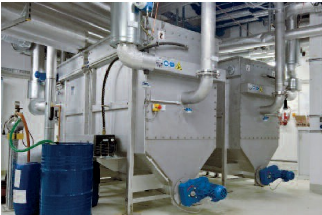
Битова отпадъчна вода; 2x RoWin 8; терм.мощност на извличане 560 kW отопляване / 1.000 kW охлаждане
