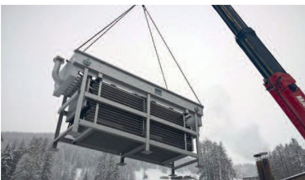
Поток на изход ПСОВ; 1x RoWin C8; без предварително пресяване, терм.мощност на извличане до 500 kW
