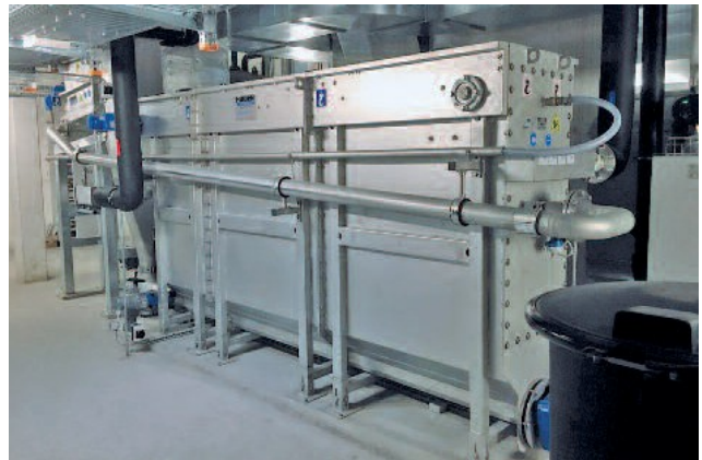
Основно натоварване скикурорт; 1x RoWin 4; предварително пресяване чрез HUBER WAP® L4; терм.мощност на извличане 150 kW
