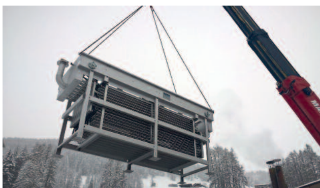
Kläranlagenablauf; 1x RoWin C8; ohne Vorsiebung therm. Entzugsleistung bis zu 500 kW
