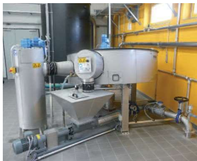
HUBER Дисков съгстител S-DISC за съгъстяване на 35 м 3 /ч
