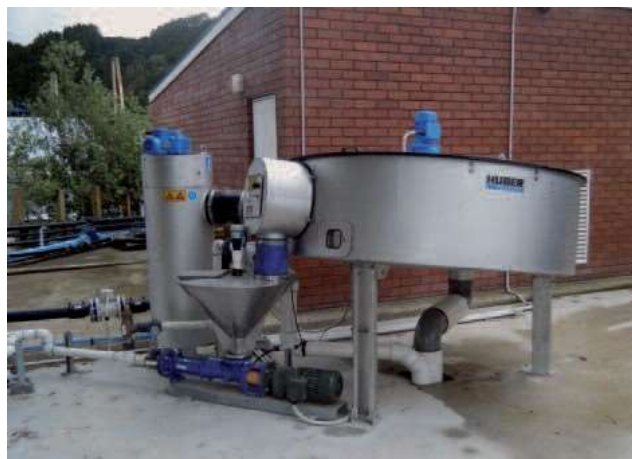
Инсталация на открито на HUBER Дисков сгъстител S-DISC
