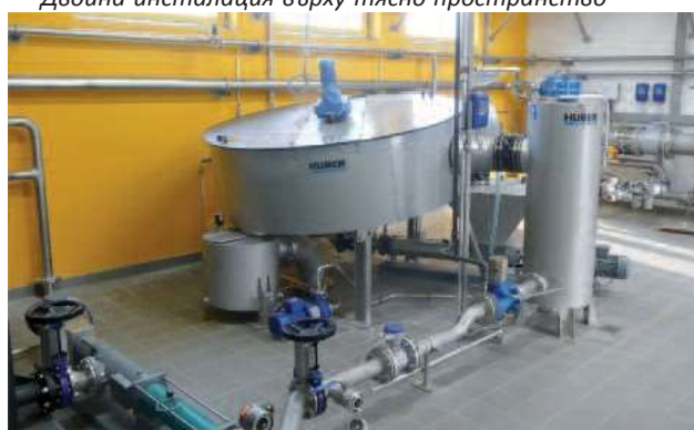
Филтратен приемник и помпа за пръскана вода ва воден кръговрат
