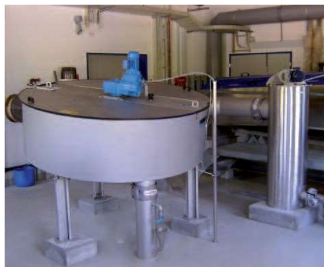
HUBER Дисков съгстител S-DISC машинна големина 2 с включен отпред реактор за флокулиране
