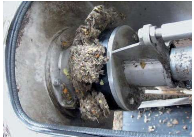
Изнасяне на отсетите и пресовани груби частици
