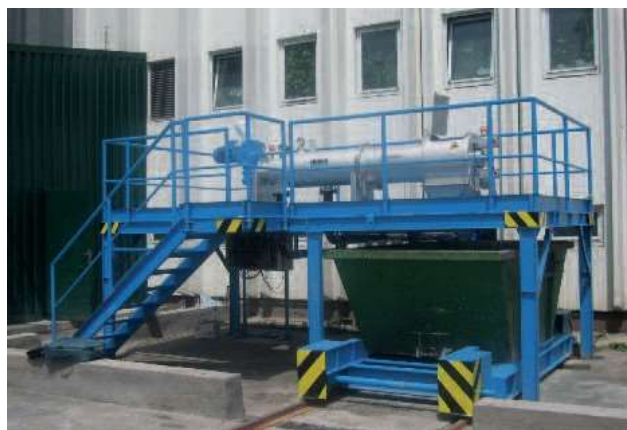
Инсталация на открито на с HUBER Сепаратор за груби частици STRAINPRESS®
