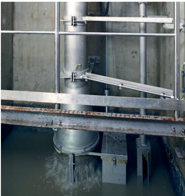
Предварително пресяване във водовземно съоръжение посредством HUBER Шахтово сито ROTAMAT® RoK4
